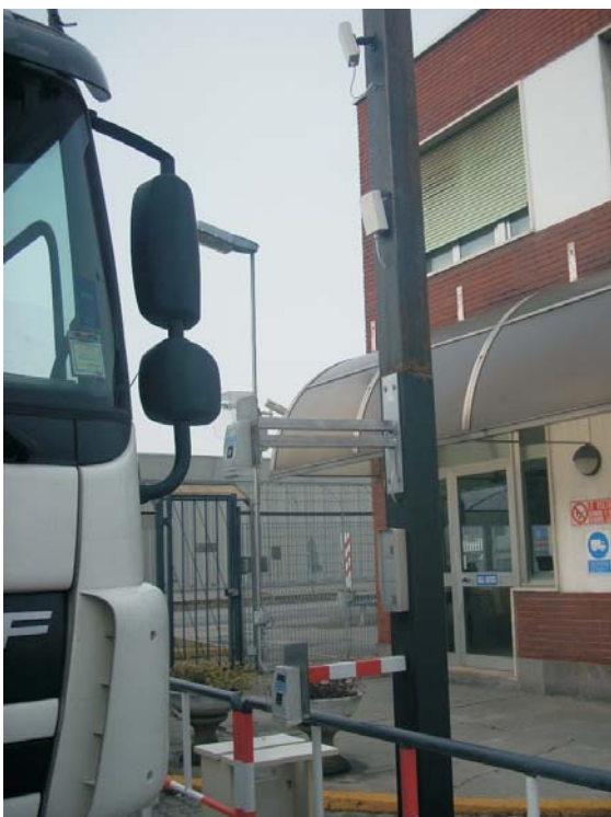
COLONNA ALL'INGRESSO DEL VARCO CON ILLUMINATORE RICEVITORE E SISTEMA BIOMETRICO PER L'IMPRONTA DIGITALE
